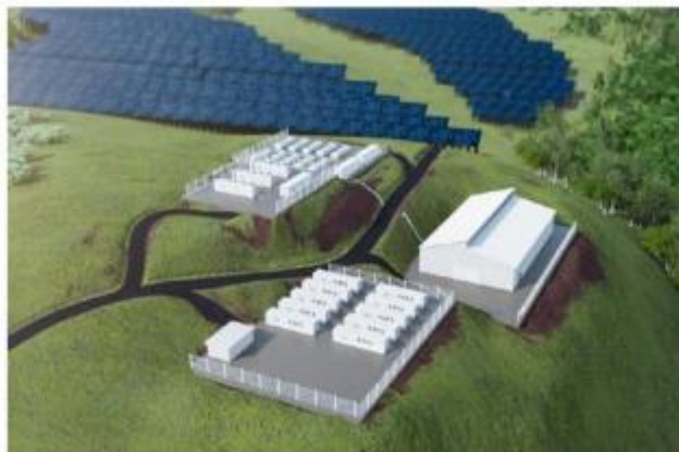
■ En Guyane, projet de centrale utilisant l'hydrogène pour stocker l'énergie produite par des panneaux solaires (HDF Energy).
